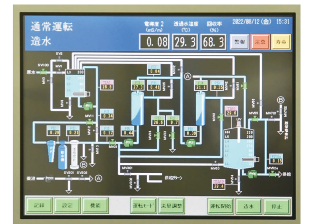
RO装置の運転状況を知らせる制御盤
